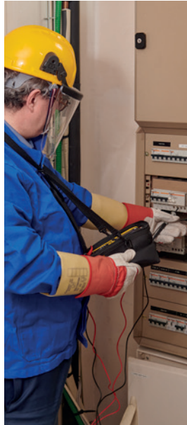
Wartungsarbeiten an einem Schaltschrank
