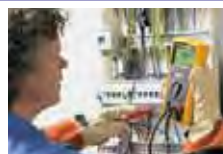
Isolationsprüfung an einer Unterverteilung
